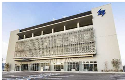
2021年4月に竣工した本社増築棟
