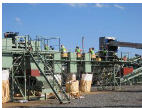
④ 廃棄物の分別作業（仮置場）
