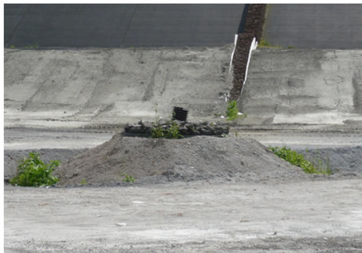
図5 ガス抜き管
