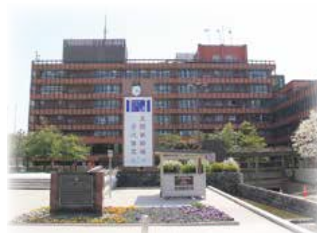
市役所第一本庁舎
