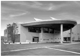
戸室リサイクルプラザ
