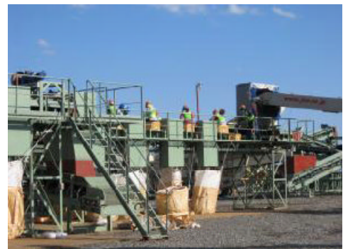
⑥廃棄物の分別作業（仮置場）
