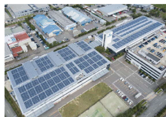
白山工場屋上太陽光パネル
