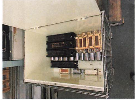
低濃度PCB廃棄物 5-2・5-3
