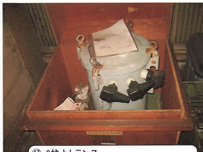
㉑-2柱上トランス 木製箱(鉄製受皿)に保管
