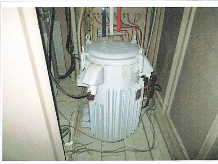
・キュービクル内機器状況 (変圧器容量: 単相30kVA) 使用中
