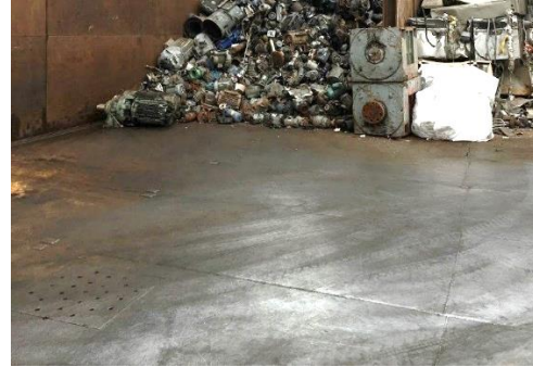
(左：ヤード床面はコンクリート（350mm）で舗装。写真は工事中のもの) (右：コンクリートの上に鉄板を敷設)
