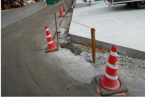
(左：ヤード床面はコンクリート（350mm）で舗装。写真は工事中のもの) (右：コンクリートの上に鉄板を敷設)
