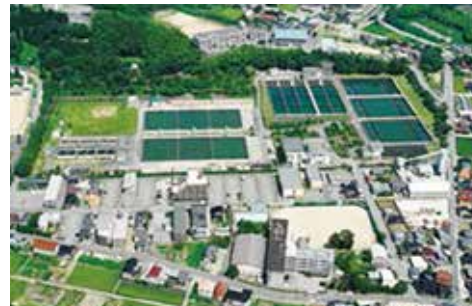
▲安心・安全な水道水を供給する末浄水場
