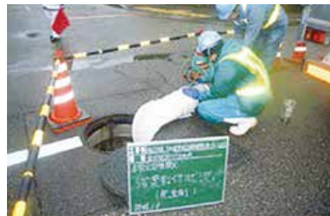
▲下水道施設の維持管理（下水道管の被膜工事）
