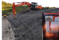
ICT施工 実施状況
