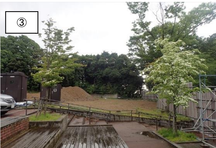
【工芸館整備箇所周辺】
