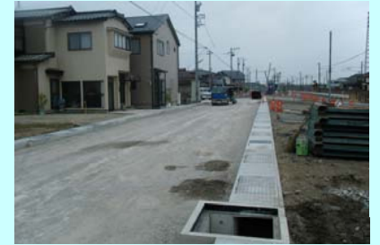
新幹線側道(糸田新町線)の整備
