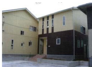
伝環区域内の総二階建ての建築物
