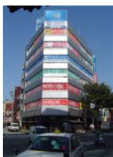
景観上支障となっている窓内側からのシール広告
