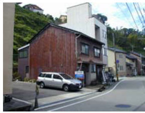
駐車場の増加が見られる こまちなみ保存区域
