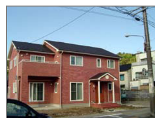
伝環区域内のレンガ調の素材を用いた洋風建築物
