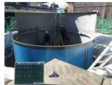
伝統的建造物群保存地区内の 防火水槽の整備
