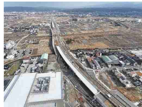
金沢外環状道路海側幹線
