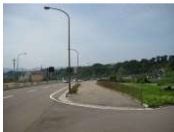
外環状道路山側幹線沿道と 斜面緑地
