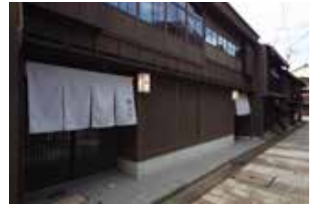
のれんや行灯を使用することで、ひがし茶屋街の歴史あるまちなみに溶け込むように配慮されたサイン
