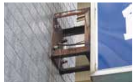
支持部は特に劣化が早く、こまめに点検することが必要です。
