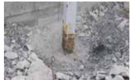
ポールの根元が錆びていると、内部も同じように錆びている可能性があります。
