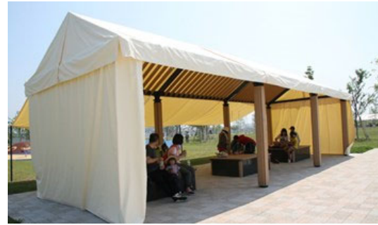
防災機能を満たす休憩施設 (神栖公園 (茨城県神栖市))
