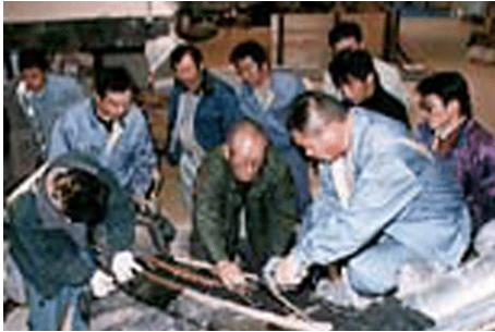
本瓦葺の作業
