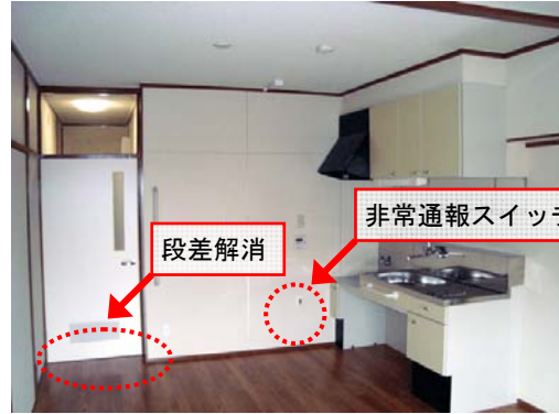
段差の解消、非常通報スイッチの設置
