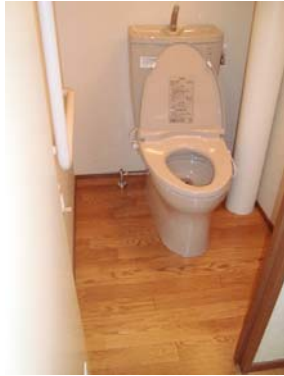
暖房便座の設置
