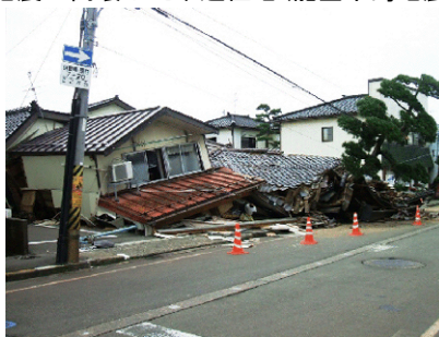
■地震で倒壊した木造住宅(能登半島地震)■
