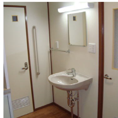
手すりの設置
