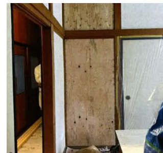
低コスト工法の一例 (既存の壁の上から耐震壁の施工)
