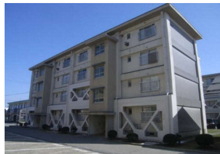
耐震改修工事を行った建築物
