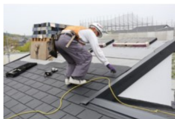
屋根の断熱化工事
