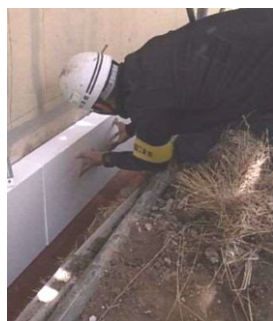
外壁の断熱化工事
