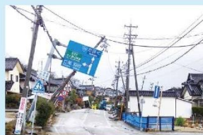
内灘町、かほく市等で液状化現象による被害が発生
