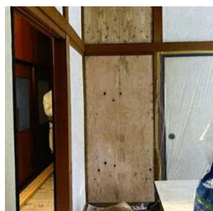
写真：第3次金沢市建築物耐震改修促進計画から引用
