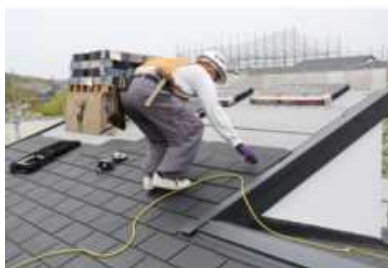
屋根の断熱化工事
