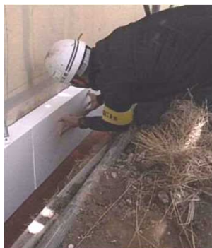
外壁の断熱化工事
