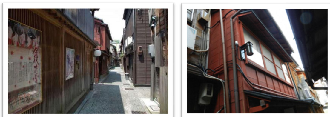
写真 2-1 軒下配線の事例（金沢市主計町）
