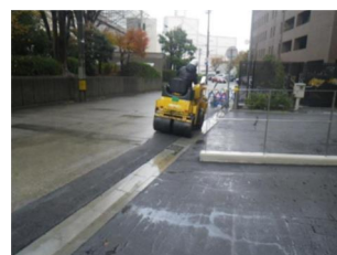
アスファルト舗装工
