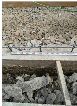
鉄筋工(差筋)
