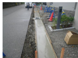
コンクリート基礎工(打設・完了)
