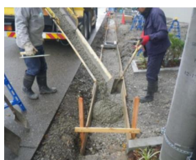
コンクリート基礎工(打設・完了)
