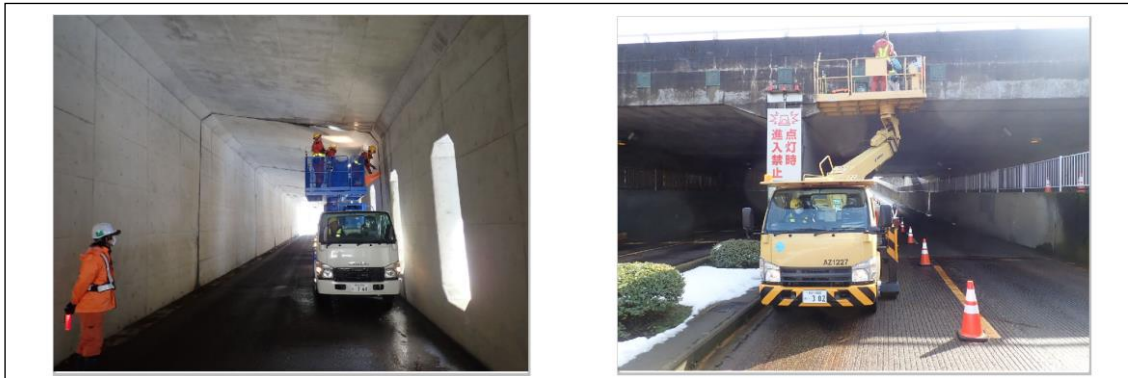
定期点検：高所作業車による近接目視
