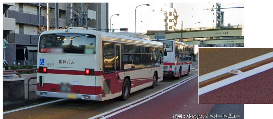
【カラー舗装と道路鋲によるバス専用レーンの明示（名古屋市 基幹バス）】
