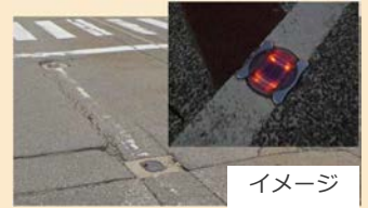
【LED道路標によるバス専用レーン明示】(金沢市内のリバーシブルレーン)
