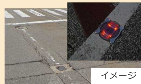
【LED道路標によるバス専用レーン明示】(金沢市内のリバーシブルレーン)
