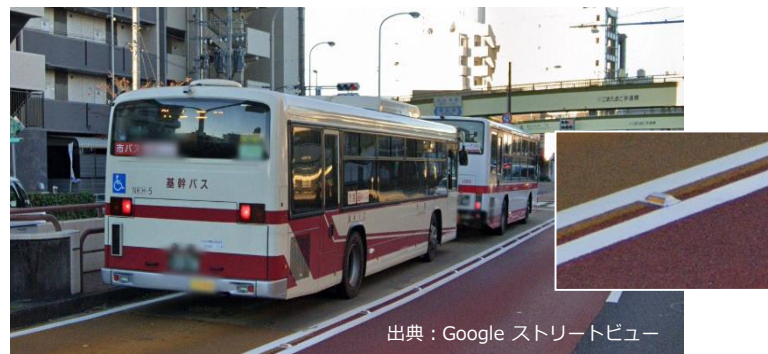
カラー舗装と道路鋳によるバス専用レーンの明示 （名古屋市 基幹バス）
