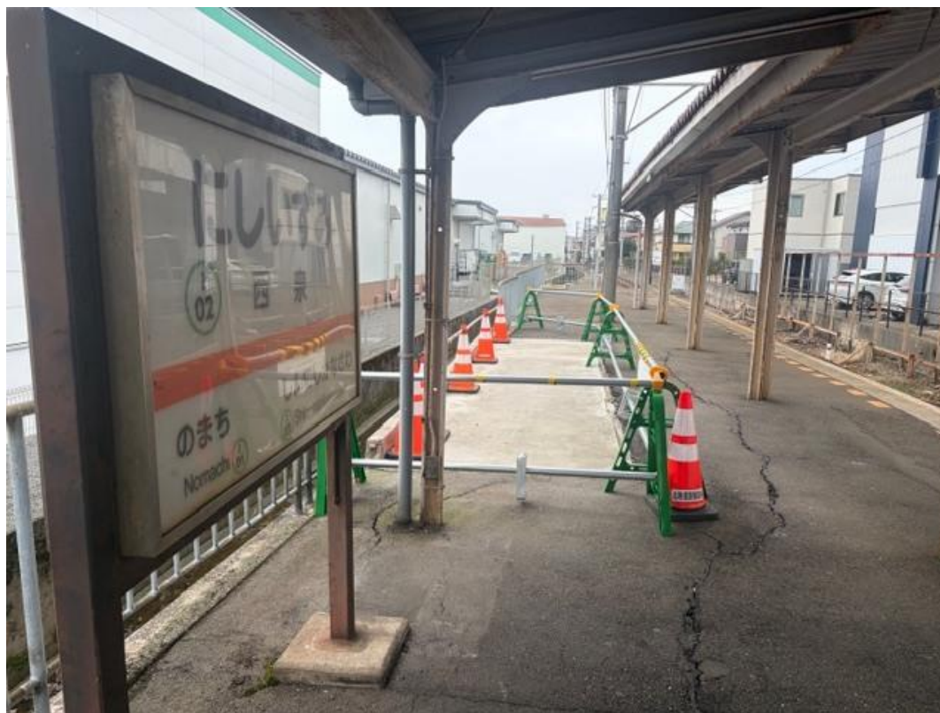
ホーム、上屋改良の準備工事として解体された待合室
