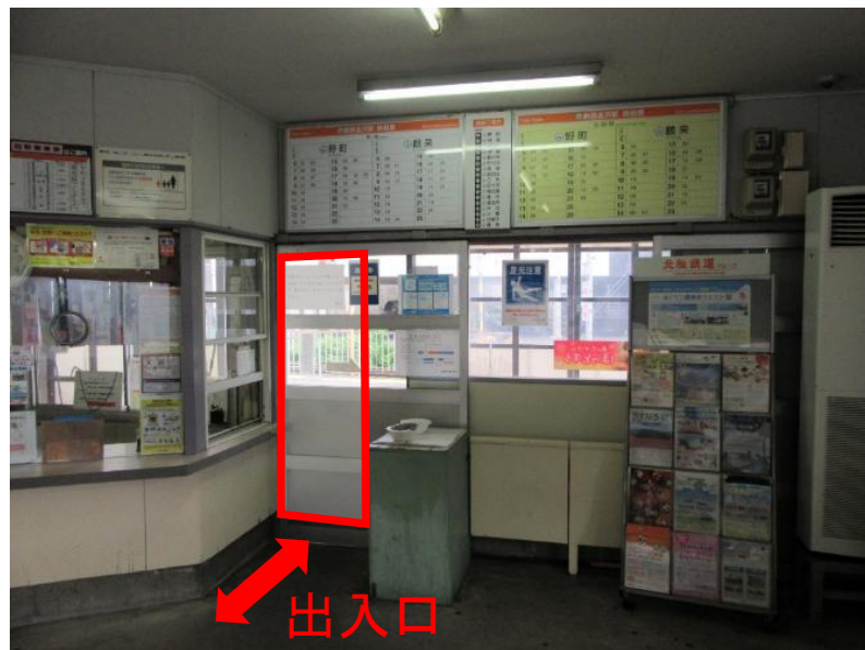
新西金沢駅 出入口通路改修前
