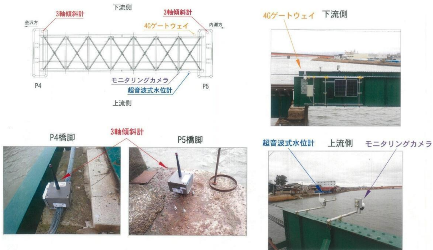
大野川橋梁 機器設置位置および完了写真
