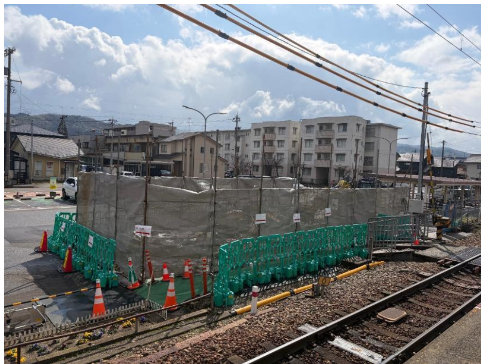
新変電所建設に伴い解体された額住宅前駅舎
