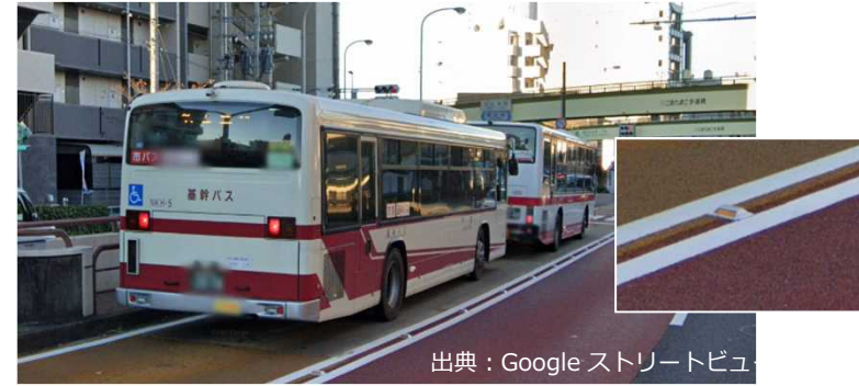
カラー舗装と道路鋏によるバス専用レーンの明示（名古屋市 基幹バス）
