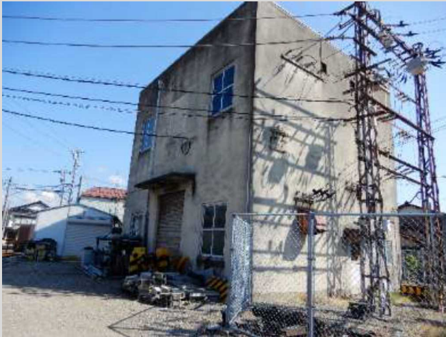
野々市変電所の建替え(石川線)
