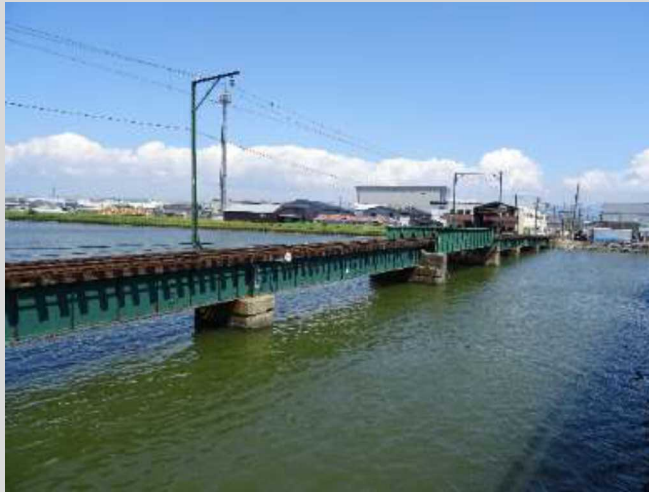
大野川橋梁の改修(浅野川線)
