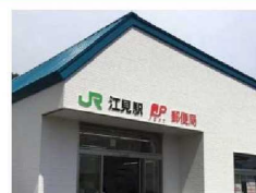
駅舎の 新築・移設
