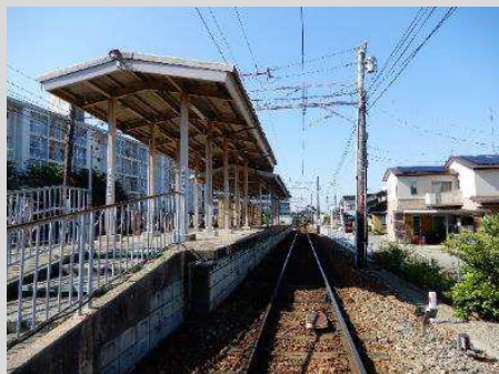
停車場や線路、電路設備等
