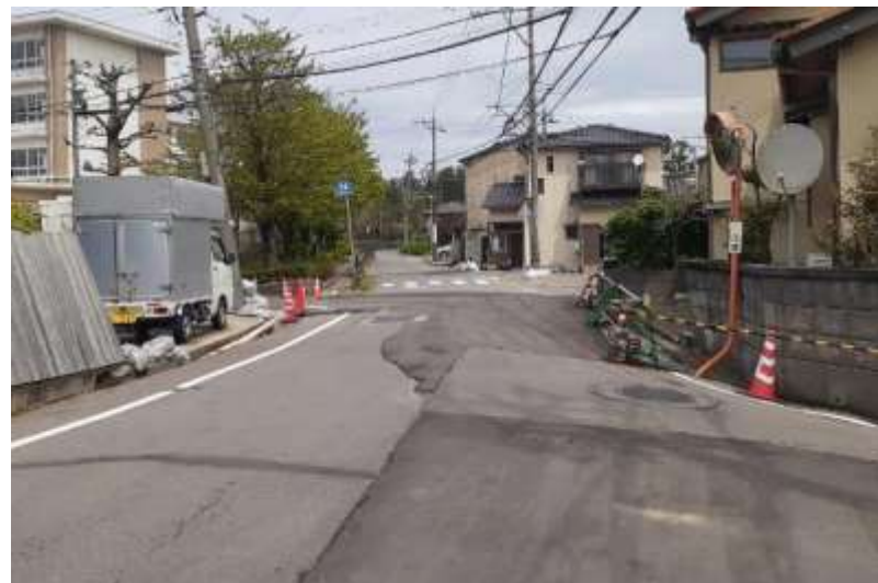
応急修理後の状況
