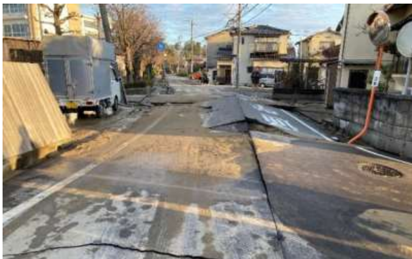
発災直後の被害状況
