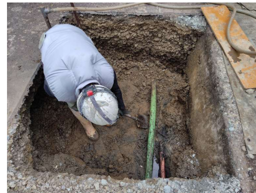
「埋設管」が破損しないよう、人力で掘削します
