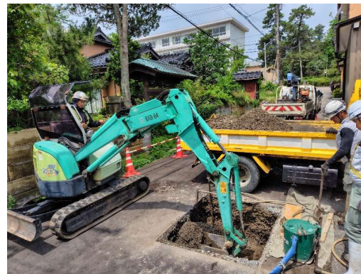
道路を慎重に掘削していきます
