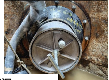
④ 集排水管設置状況 鋼管内に集排水管を設置
