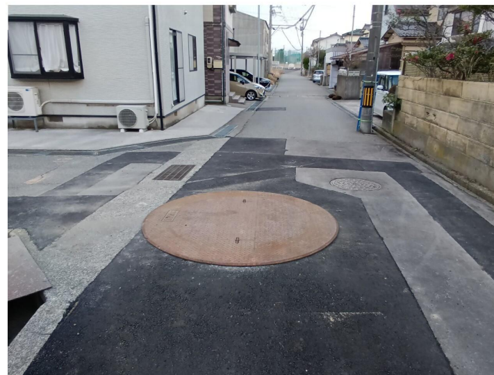
覆工板設置完了
