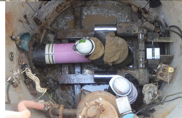
④ 集排水管設置状況 鋼管内に集排水管を設置
