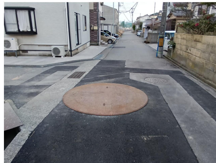
覆工板設置完了
