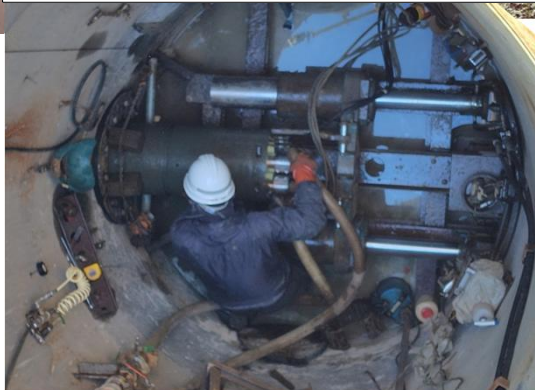
② 推進状況 先導管の後ろに鋼管を つなぎ押し込んでいく
