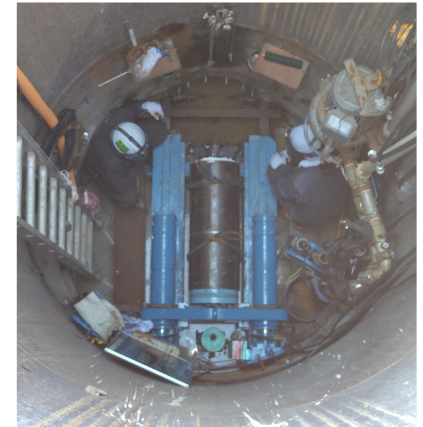
施工状況(立坑内の様子)
