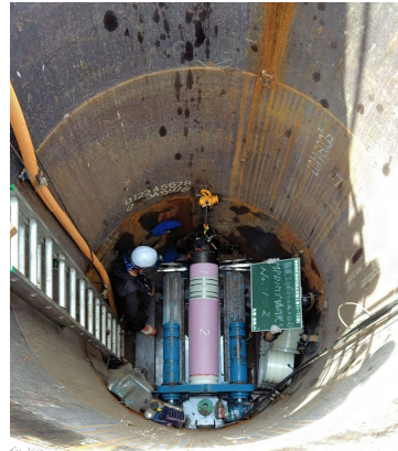
施工状況(集排水管設置状況)
