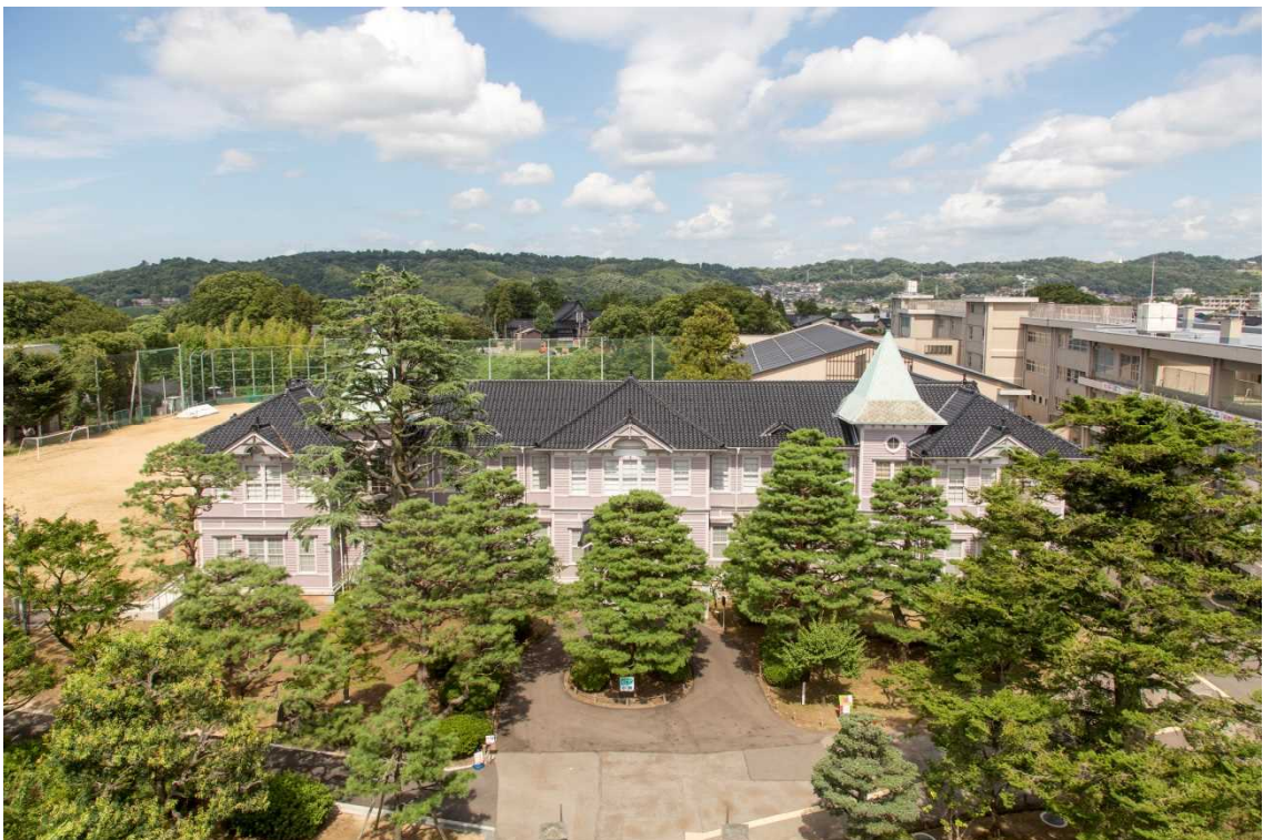
旧石川県第二中学校本館全景（南西から）
