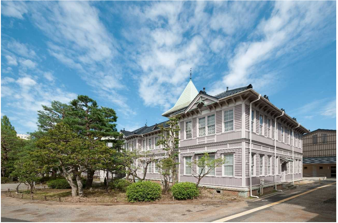
正面外観（南から）
