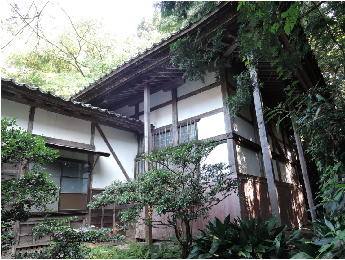
御霊堂正面 北西より撮影
