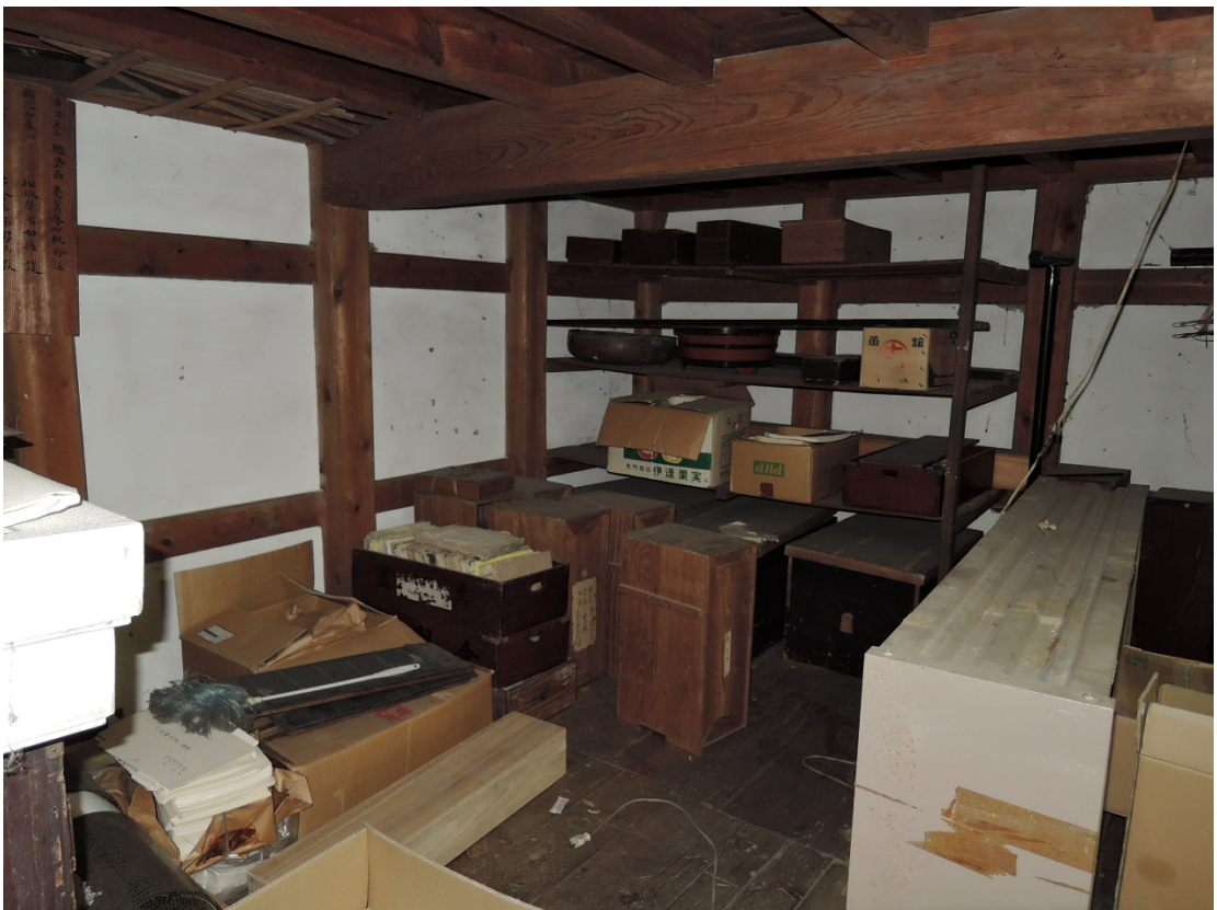
碧巖蔵 2階内部 南西より撮影
