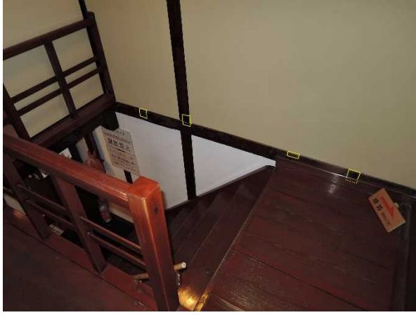
旧階段痕跡（黄色囲み部分）
