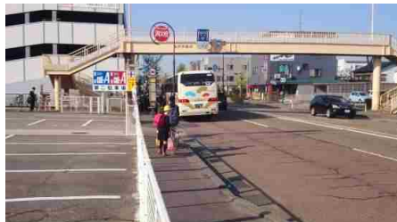
歩道拡幅整備(石川県)
