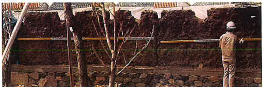
通用門口土塀解体時写真 「国立金沢病院土塀分析調査報告書」 (昭和58年4月、大成建設株式会社) より 内部版築を撮影
