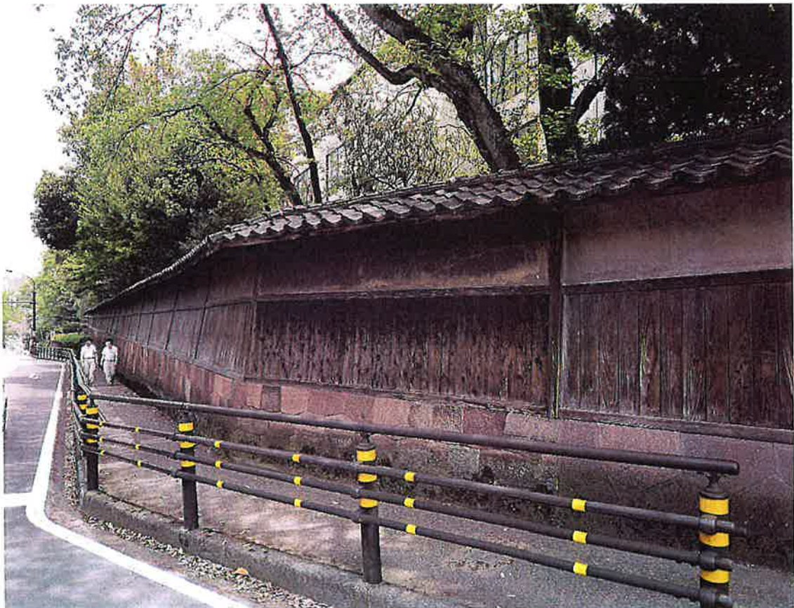
写真2 正面門左側土塀 尻垂坂沿い
