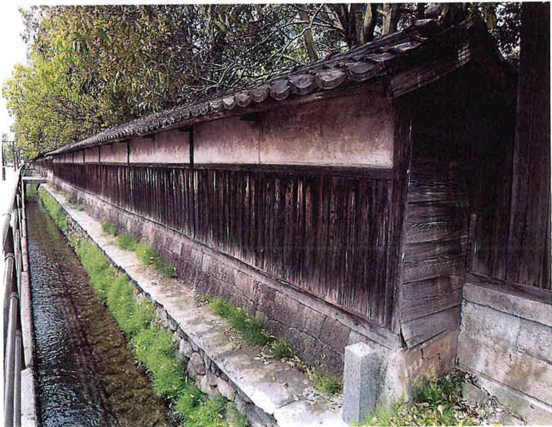
写真4 通用門右側土塀
