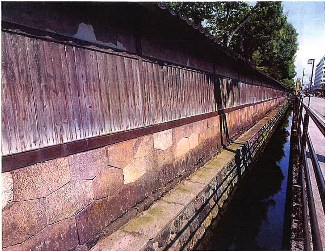
写真1 正面門左側土塀 辰巳用水沿い
