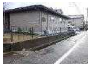
転落防止柵の設置(市)
