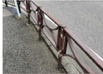
防護柵の更新（県）
